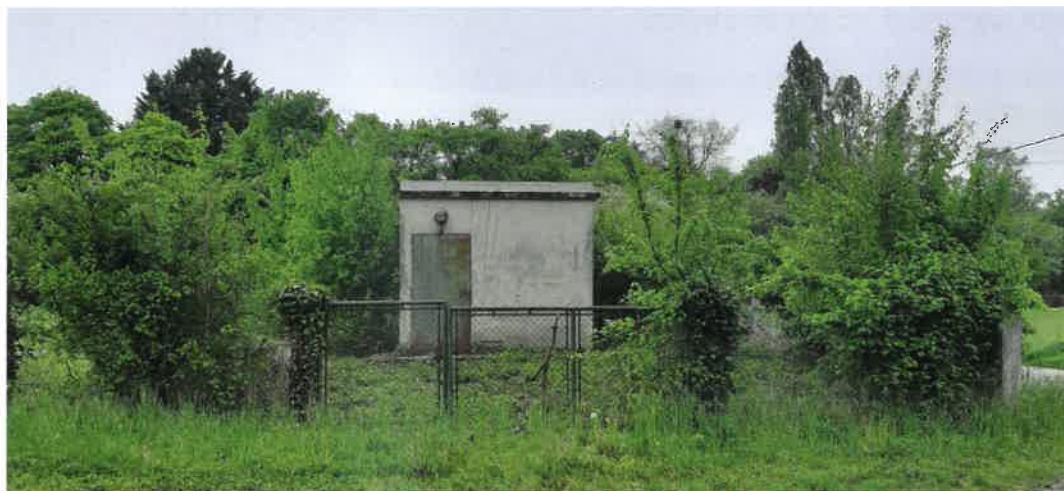
Local du surpresseur situé dans le bas de la rue des Casseriaux en limite de Fussy
