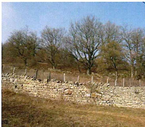
Mur de clôture en pierres sèches
