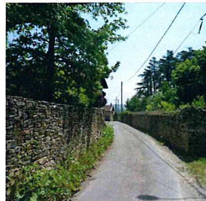
Mur de clôture structurant la rue
