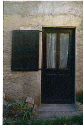
2 - porte vitrée avec volet sur gonds déportés
