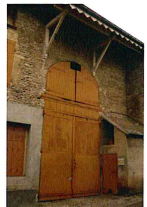
8 - porte charretière composée avec une baie en plein cintre superposée donnant dans le grenier
