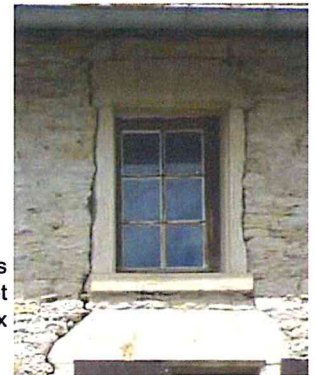
Menuiserie bois à un vantail et petits carreaux
