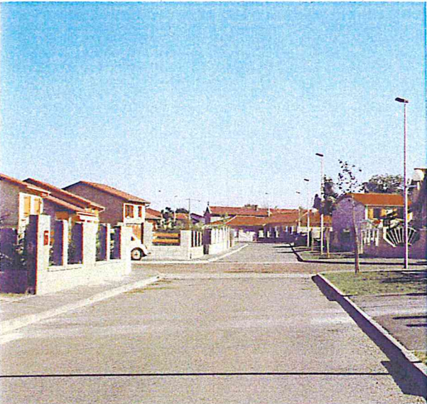
Un axe rigide : ambiance minérale et froide. La végétation est insuffisante et jeune.
