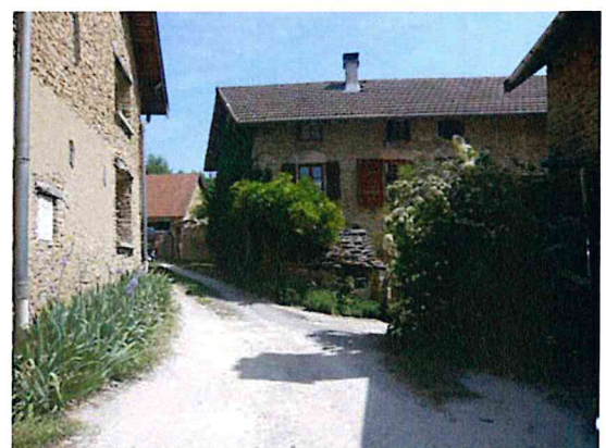
La végétation accompagne les murets, agrmente le pied des murs tout en les laissant respirer (l'humidité des murs s'évacue).
