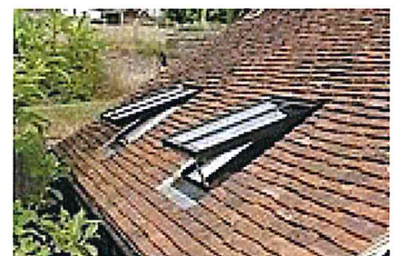
Modèle de châssis de toit en métal type "patrimoine" inspiré des tabatières anciennes, parfaitement adapté au caractère des toits de la commune
