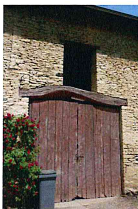
6 - porte charretière en planches verticales
