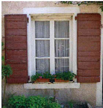
Menuiserie bois à deux vantaux et grands carreaux
