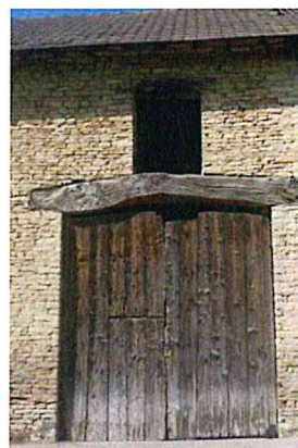
7 - porte charretière en planches verticales avec guichet
