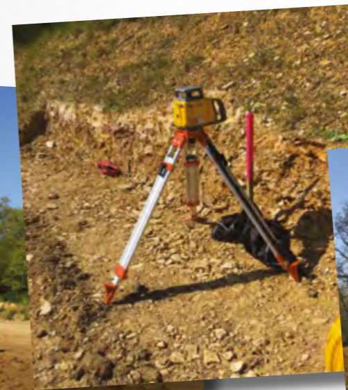
Travaux au nouveau terrain de foot
