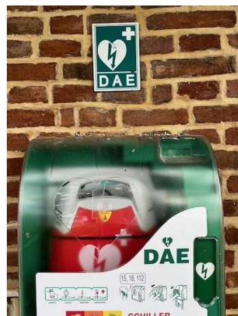
Installation d'un défibrillateur En façade de la mairie
