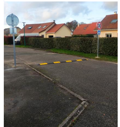
Installation d'un ralentisseur rue des Bleuets
