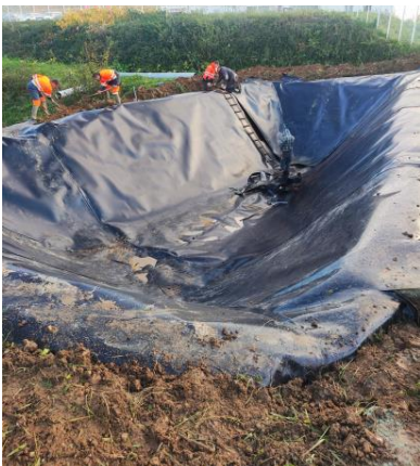
Remplacement de la bâche au bassin de la zone d'activités du Calvar.
