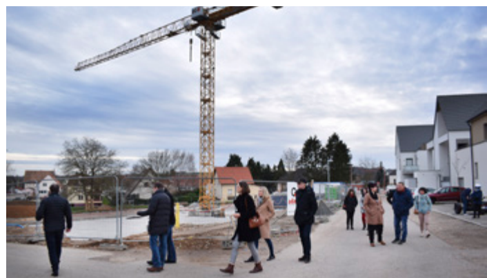
Visite chantier école
