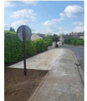
Aménagement places de stationnement rue de Grez
