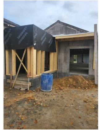
Travaux aménagement groupe scolaire
