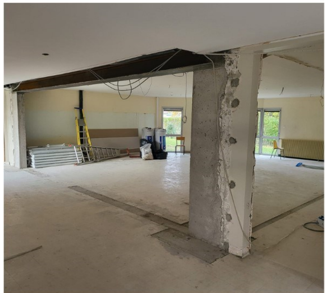
Travaux aménagement groupe scolaire
