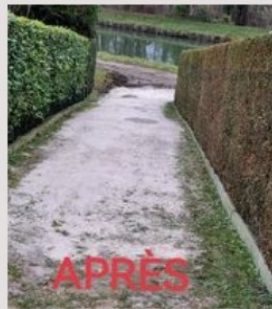
Réfection accès chemin de halage
