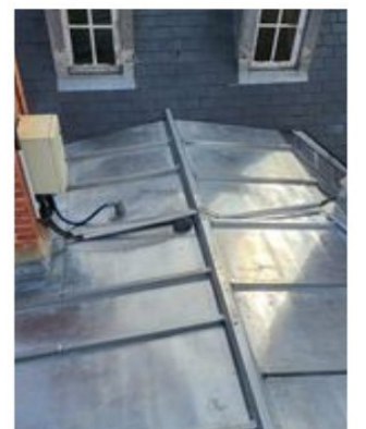
Réfection toitures bâtiments communaux
