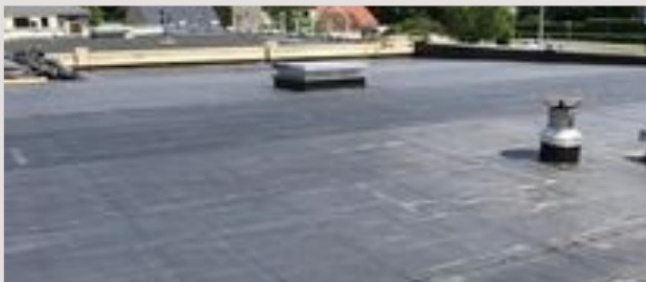
Réfection toitures boulangerie et Cocci Market, propriétés de la commune
