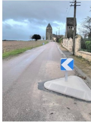
Installation d'écluses rue de l'église
