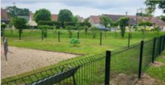
Clôture aire de jeux route de Moret
