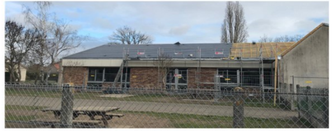
Réfection toiture de l'école élémentaire
