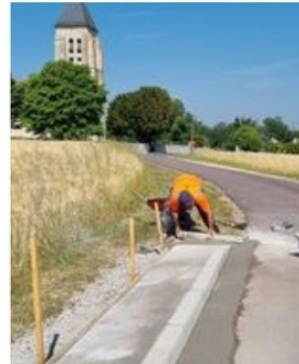
Aménagement carrefour des 3 tilleuls
