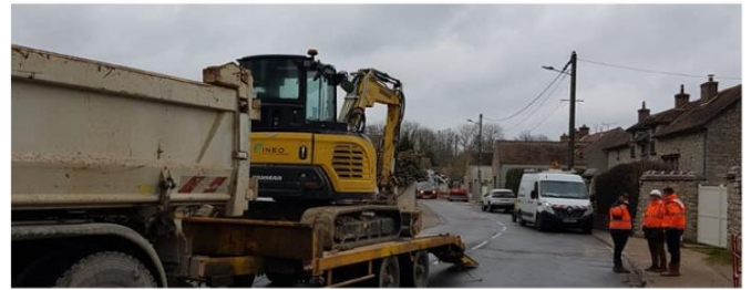
Enfouissement des réseaux rue de Grez
