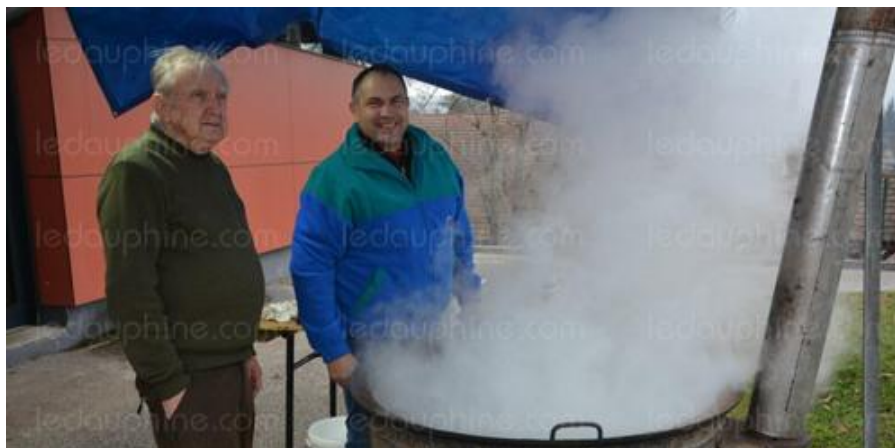
Autour de la chaudière à bois, Gilles Vidon, à gauche, et Christophe Bourg.
