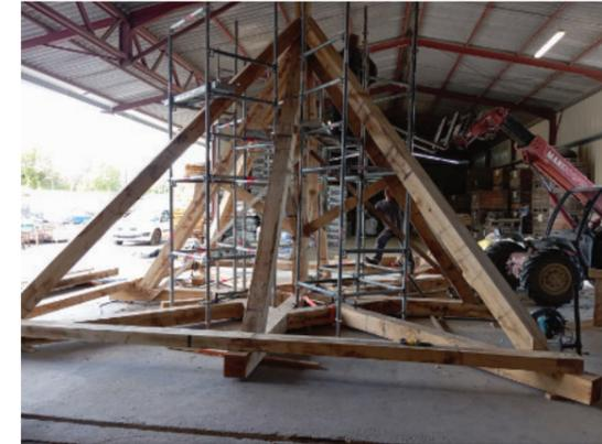
Fabrication de la charpente en atelier. Pré-montage (nov. 2023)
