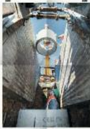
Les travaux à Ste Ève en 2016
