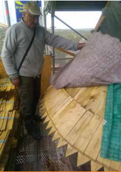
André Capdecombe, maître charpentier Mirandais à la retraite découvre le départ d'une poivrière (petit clocher).
