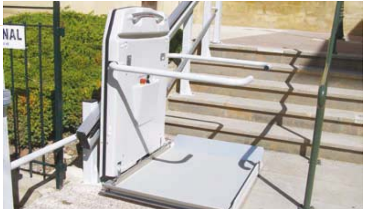
Monte-Éscalier réalisé dans le cadre de l'amélioration de l'accessibilité aux personnes à mobilité réduite, pour permettre, à tous, l'accès aux nouveaux locaux de la Communauté de Communes.
