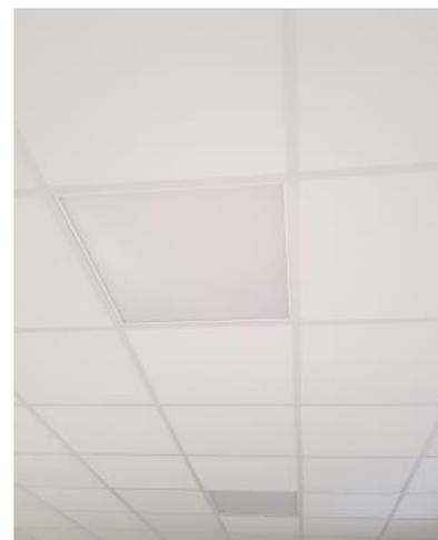
Installation d'un faux plafond et pose de luminaires LED dans les classes.
