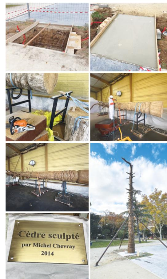
**CÈDRE.** Préparation de la fosse, fabrication et pose du ferrillage, béton coulé, tronçonnage du pied, sablage, nettoyage par aérogommage, plaque prête à l'accueillir, enfin le retour!
