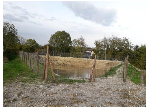
La réalisation d'un bassin d'infiltration pour la gestion des eaux pluviales du chemin du moulin
