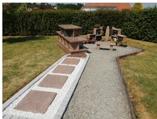
L'extension du columbarium et la mise en place de cavurnes
