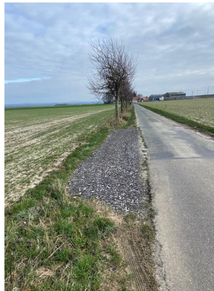
Des aménagements sur voiries sur le secteur de Cormette
