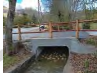
Pont de la Bergogne
