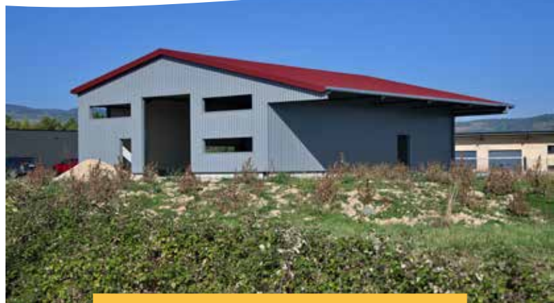
Le futur bâtiment d'un menuisier
