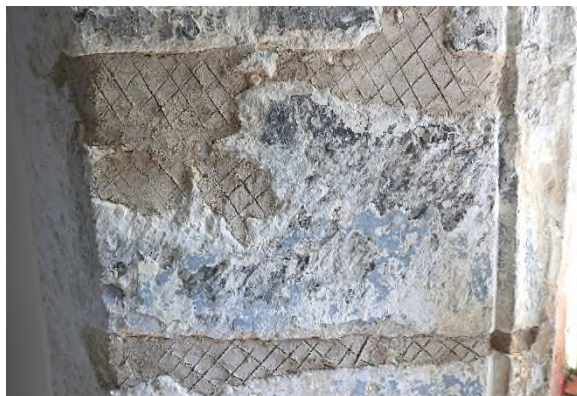
Fig.19. Ébrasement dextre en cours de colmatage des lacunes profondes.
