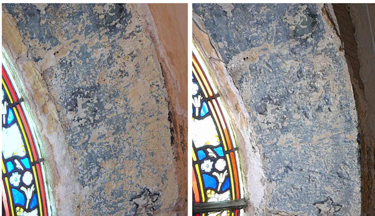
Fig.11. Détail de la partie supérieure d'ébrasement senestre de la baie avant dégagement.
