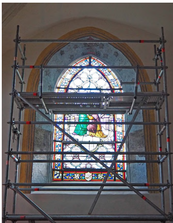
Fig.38. Vue générale après intervention.
