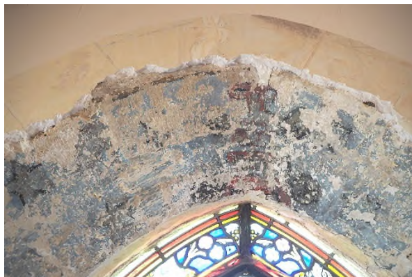
Fig.35. Sommet de la baie avant intervention.
