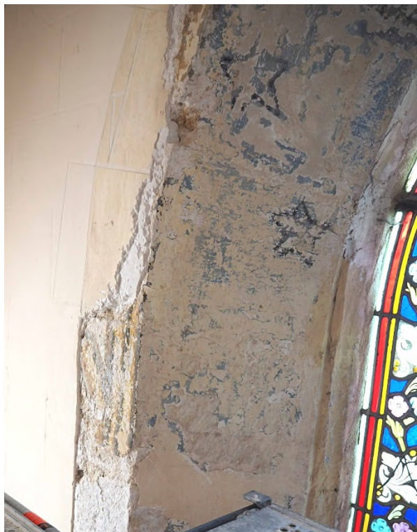
Fig.31. Ebraselement dextre avant intervention.
