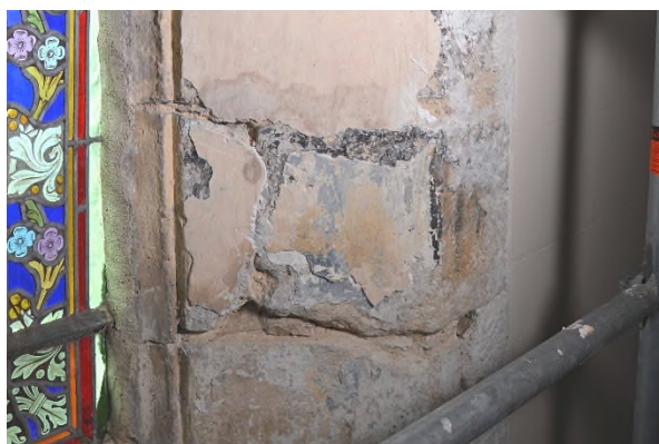
Fig.17. Détail de la partie inférieure d'ébrasement senestre de la baie avant dégagement.
