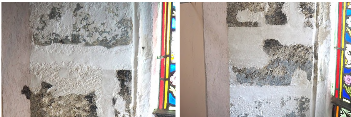
Fig.27 et 28. Ébrasement dextre après pose de badigeon sur les colmatages et sur les lacunes de la couche picturale.
