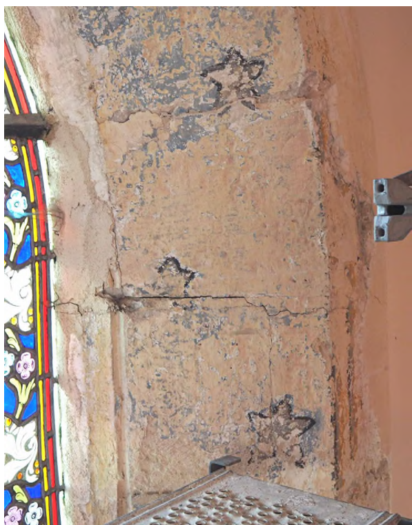
Fig.33. Ebraselement senestre avant intervention.
