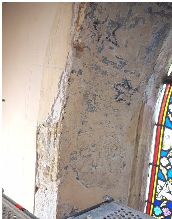
Fig.13. Détail de la partie supérieure d'ébrasement dextre de la baie avant dégagement.
