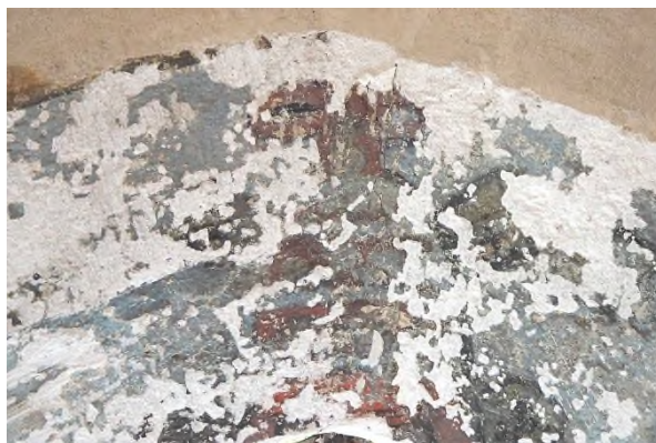
Fig.26. Détail du sommet de la baie après pose de badigeon sur les lacunes de la couche picturale.
