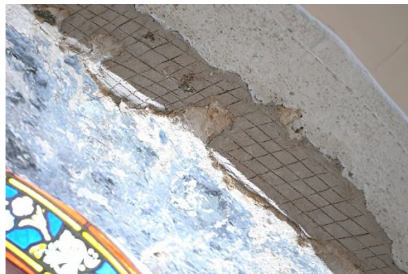
Fig.20. Partie supérieure senestre en cours de colmatage des lacunes profondes.
