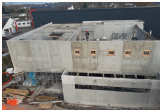
↑ Photo prise le 29 novembre 2023. Finition des dalles de couverture.
