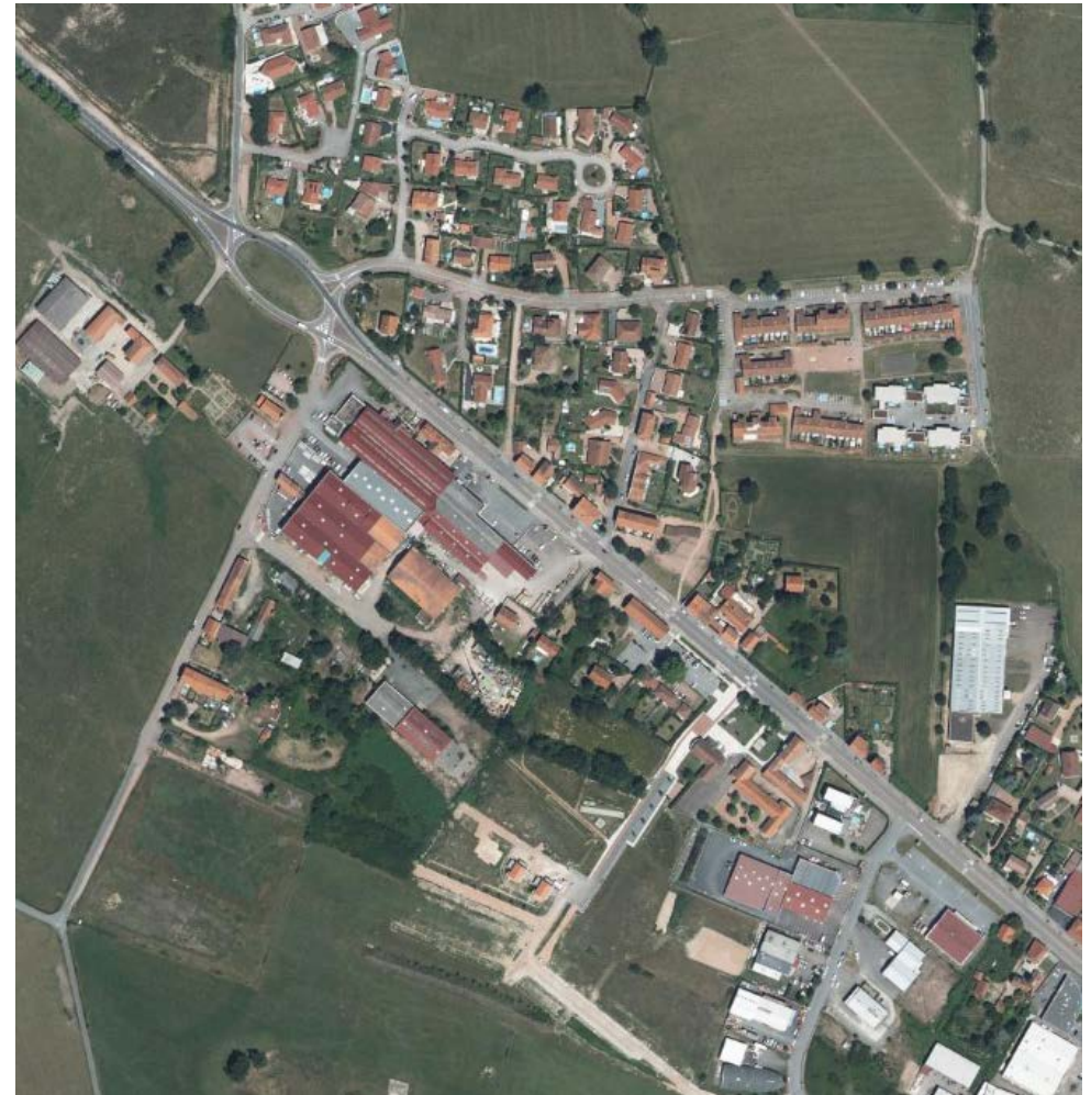
Photographie aérienne du secteur de l'OAP des Tuileries (2023)
