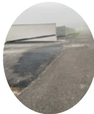
Reprise et busage du fossé chemin du Sablat Société Prat TP Total = 1 680 €
