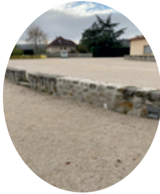
Réparation du mur place mairie Stone-rénovation d'Ecotay Total = 2 316 €
