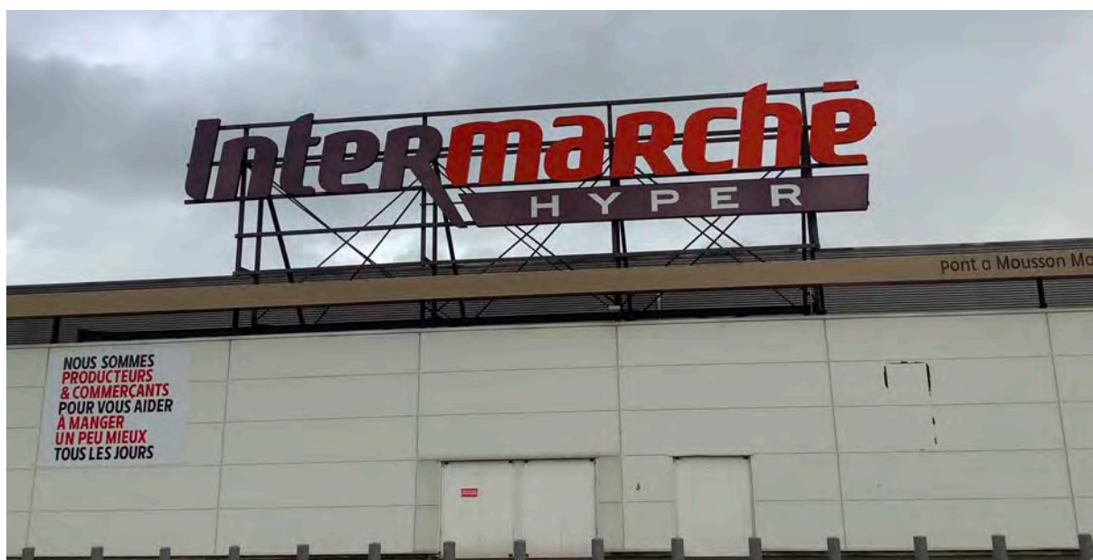
Enseigne sur toiture de grand format, Pont-à-Mousson, novembre 2022.
