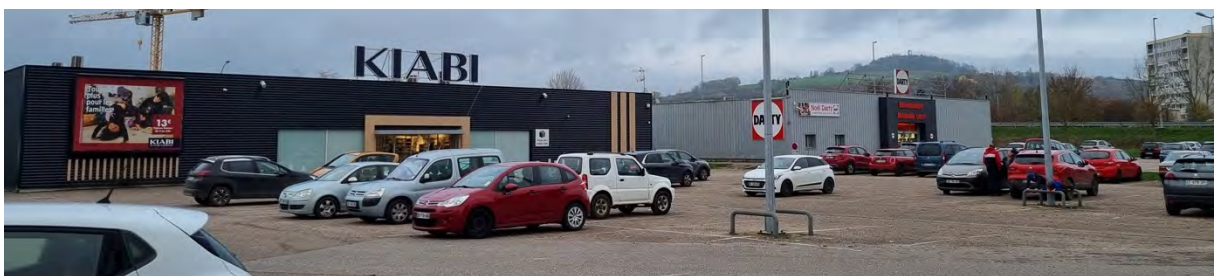
Zone d'activité du Breuil à Pont-à-Mousson, décembre 2022
