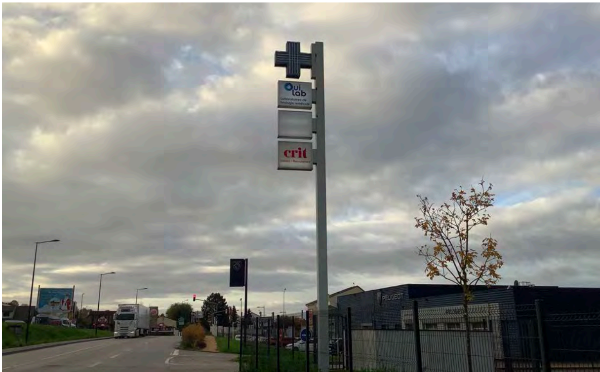
Enseigne scellée au sol avec une hauteur excessive, Pont-à-Mousson, novembre 2022.
