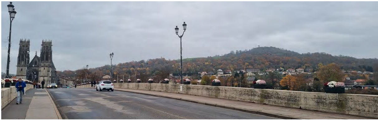
Vue sur la colline de Mousson depuis le Pont Gélot à Pont-à-Mousson, décembre 2022
