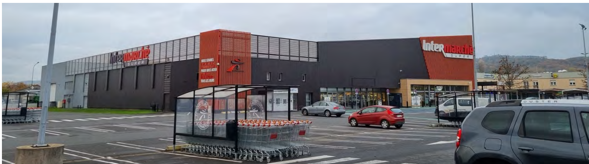
Zone d'activité du Breuil à Pont-à-Mousson, décembre 2022
