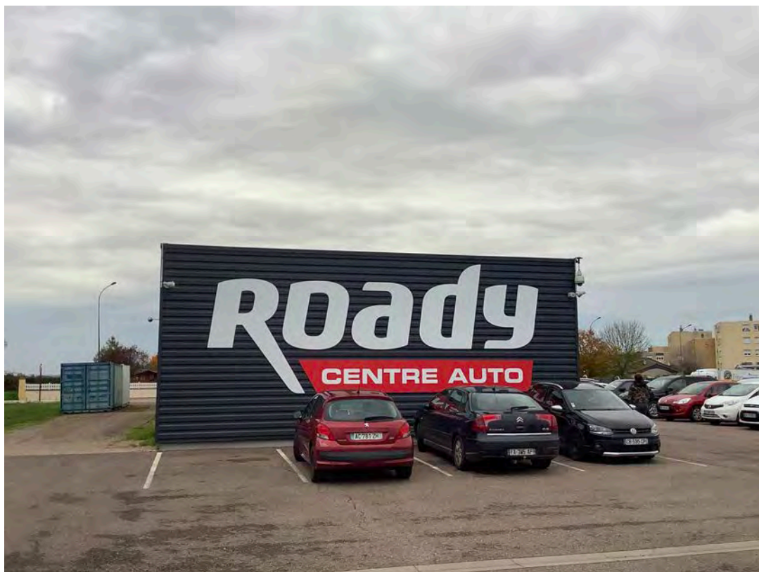
Façade commerciale dépassant à priori le seuil autorisé de surface cumulée d'enseigne sur façade, Pont-à-Mousson, novembre 2022.
