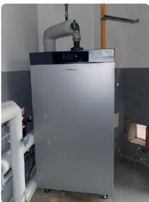
Remplacement de la chaudière fioul par une chaudière gaz au foyer
