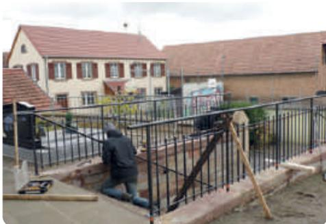
Mise en sécurité de l'escalier de l'église avec la pose d'un garde-corps et d'un grillage sur le mur extérieur
