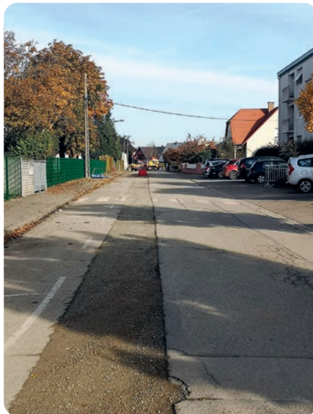
Rue du collège tranchée SDEA
