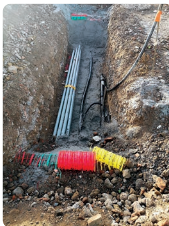
Tubes de Gaz, télécom et électricité
