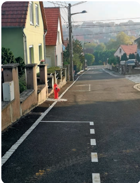
Traçage des cases de stationnement rue Pasteur
