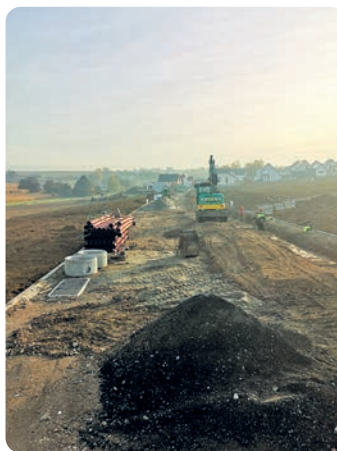
Travaux de voiries en cours
