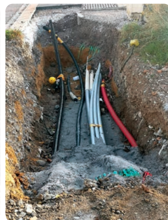
Tubes de Gaz, télécom et électricité
