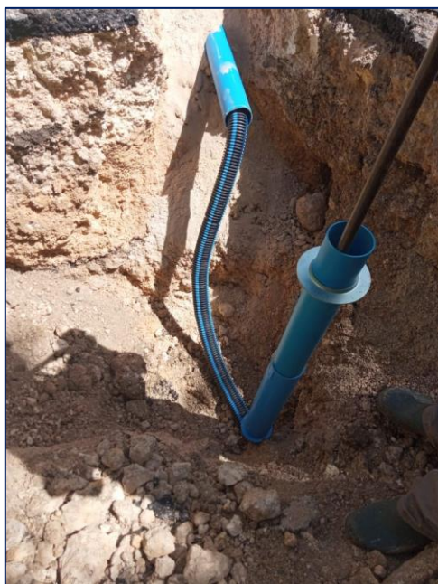
Photo 1 : Renouvellement de branchement en traversée de route, protection par gaine et fourreau PVC
