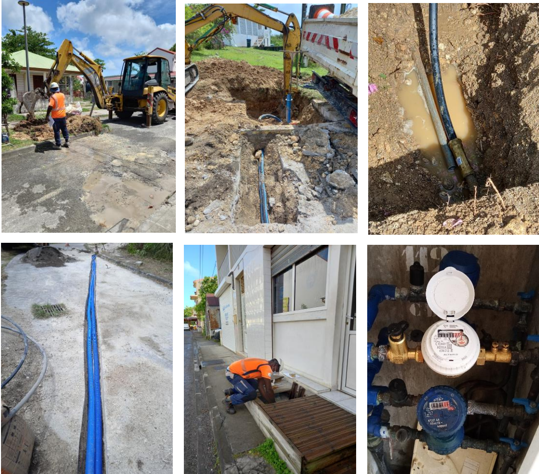
Photos : Actes courants d'exploitation en 2021 (renouvellement de branchement, branchement neuf, réparation fuite, renouvellement de compteur)
