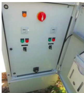
Pose des nouveaux coffrets de commandes
