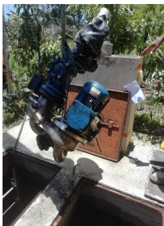
Extraction de l'ancienne pompe
