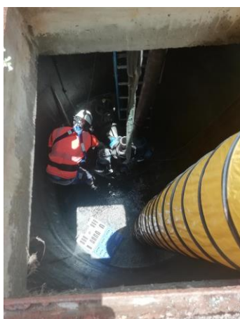
Démontage des anciens équipements (travail en espace confiné)
