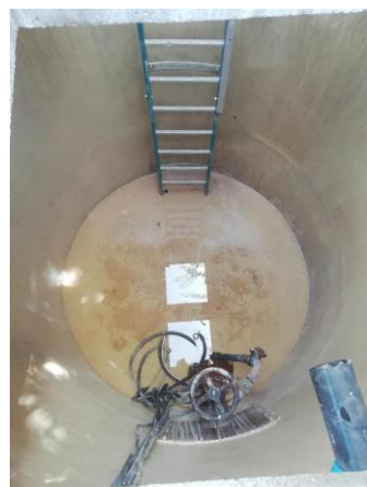
Réalisation des travaux d'étanchéité (1ère couche)
