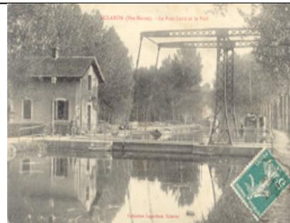
*A simple voie, les bateaux pouvaient y circuler avec un tirant d'eau de 1.80 m. Aucun bateau à vapeur ou propulsion mécanique ne pouvait circuler sur le canal de Saint-Dizier à Wassy sans une autorisation spéciale de l'ingénieur en chef du contrôle à Chaumont. La traction des bateaux le long de ce canal s'effectuait donc par l'intermédiaire du chemin de halage (chemin aménagé en bordure du canal) et s'effectuait suivant deux modes:*
