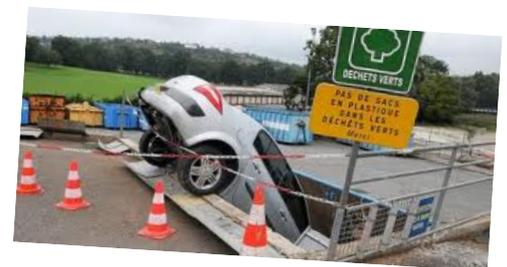
**"Les déchetteries sont des sites soumis aux réglementations des Installations Classées pour la Protection de l'Environnement. A ce titre, la présence et la fermeture des garde-corps normés est obligatoire, dès lors que la hauteur du quai est supérieure à un mètre.**
