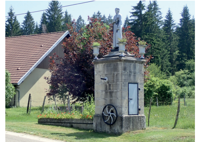
E - Réservoir du Père Receveur
