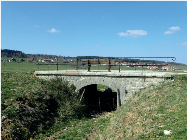
N - Pont en pierre
