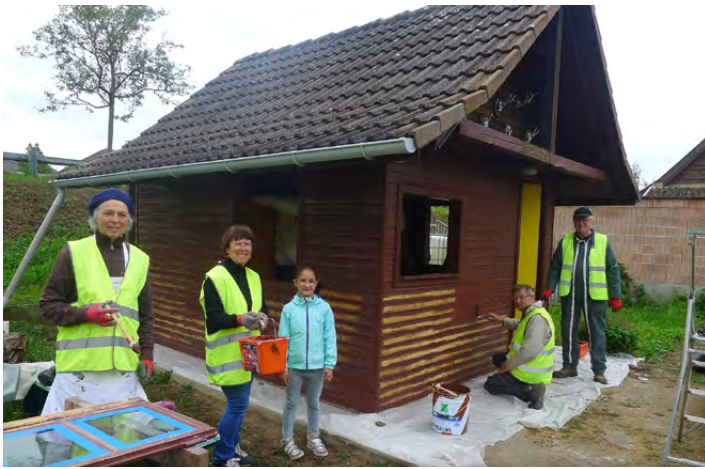
Atelier rénovation du cabanon du jardin partagé
