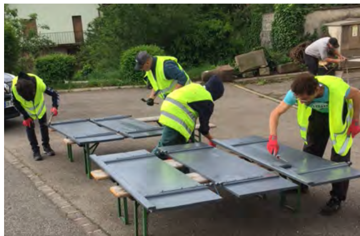
Atelier rénovation volet de la mairie
