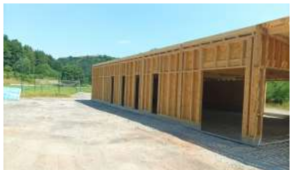
Aménagement des abords
