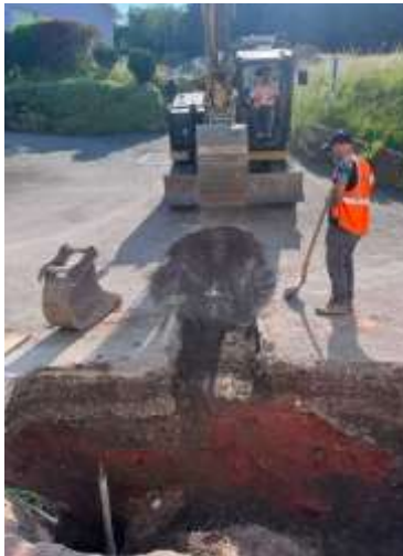
Réalisation de la tranchée pour le raccordement de la nouvelle conduite au réseau existant
