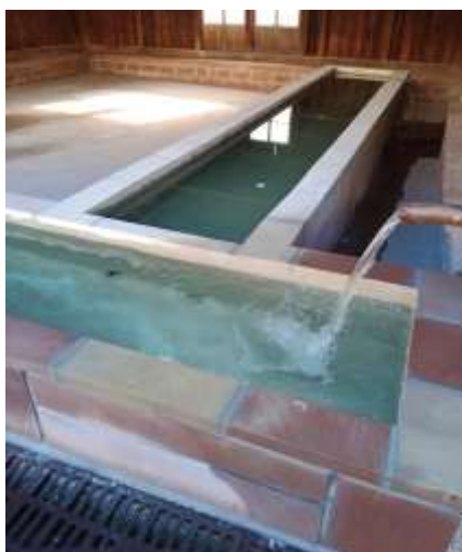
Application de grès des Vosges sur les bassins et connexion du lavoir à l'éclairage public
