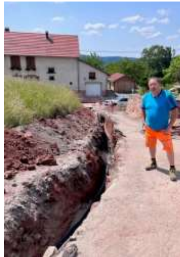
Réalisation de la tranchée pour le raccordement de la nouvelle conduite au réseau existant
