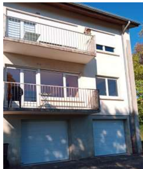
Remplacement des portes de garages et des volets roulants
