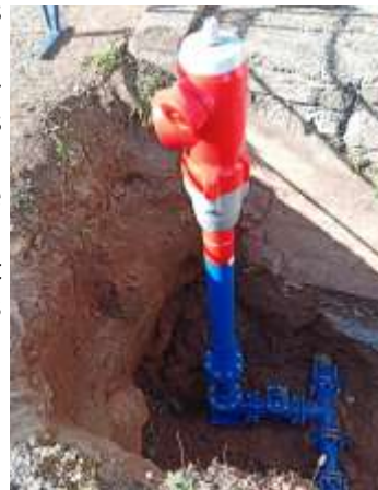
Remplacement d'hydrant
