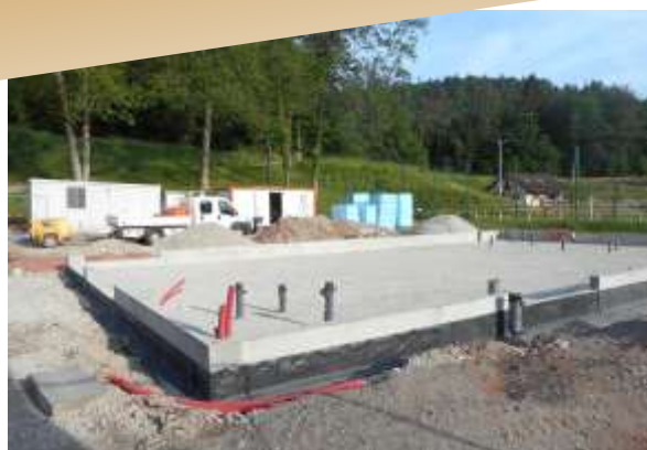
Terrassement et fondation
