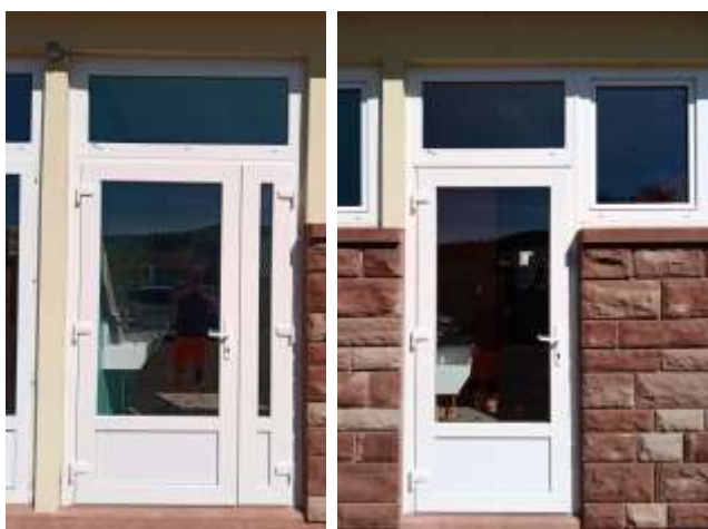
Remplacement de portes extérieures à l'école élémentaire
