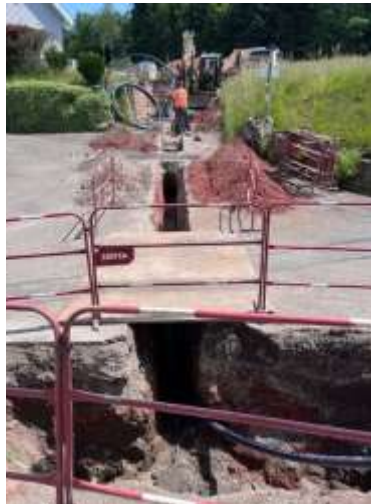
Réalisation de la tranchée pour le raccordement de la nouvelle conduite au réseau existant
