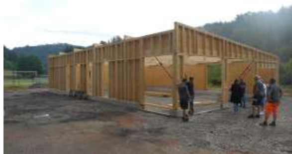
Elévation des murs et de la charpente
