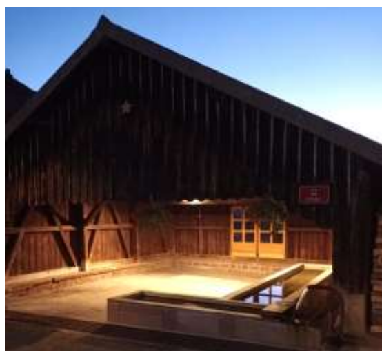
Application de grès des Vosges sur les bassins et connexion du lavoir à l'éclairage public
