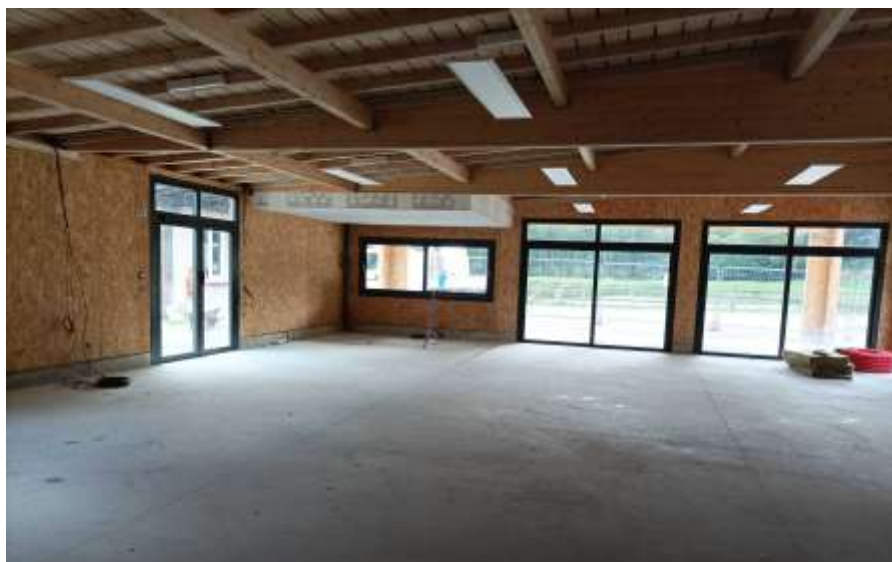
Aménagements intérieurs (plâtrerie, électricité, plomberie, sanitaires...)
