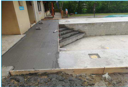
Piscine en construction
