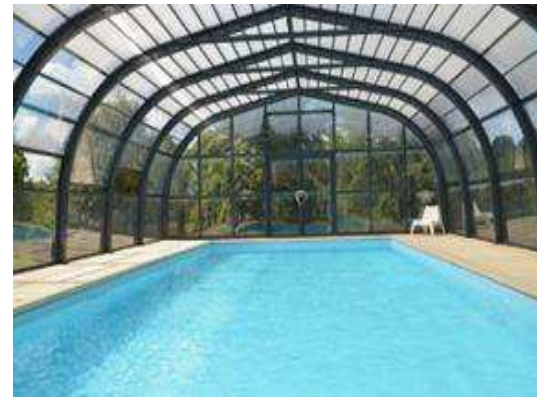
Piscine en fonctionnement
