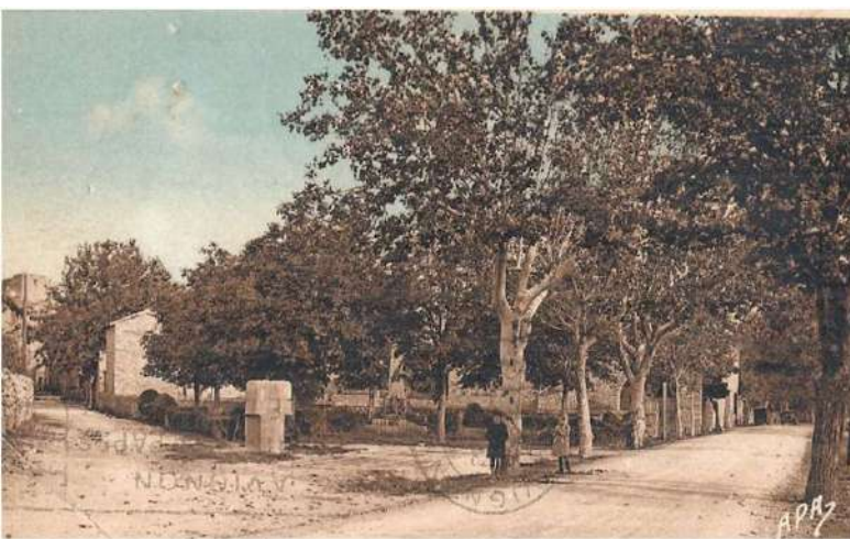
Construction du chemin neuf bordé de platanes
