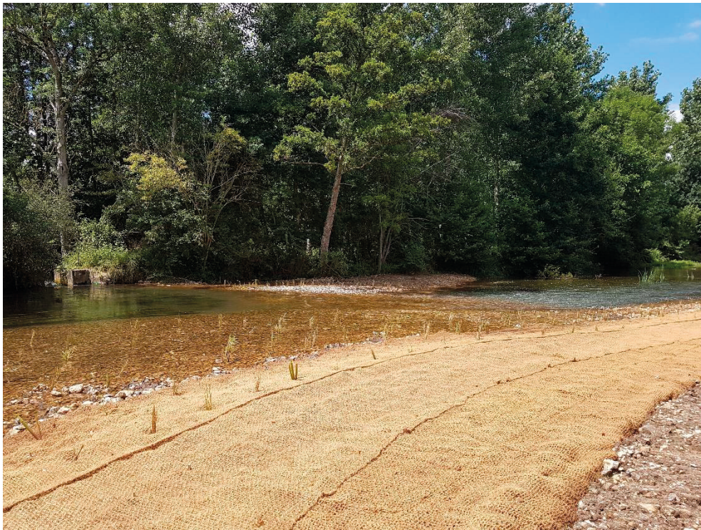
Vue après travaux – juillet 2022 – Rehausse du niveau d'eau et banquettes végétalisées
