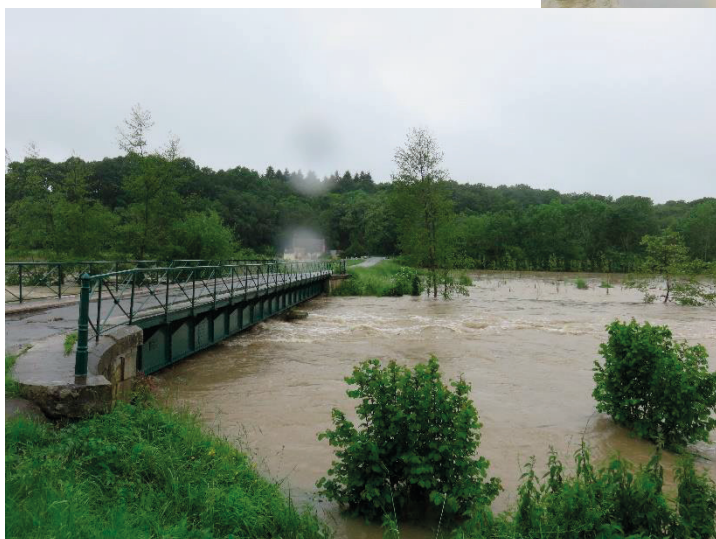
Pont du Loing
