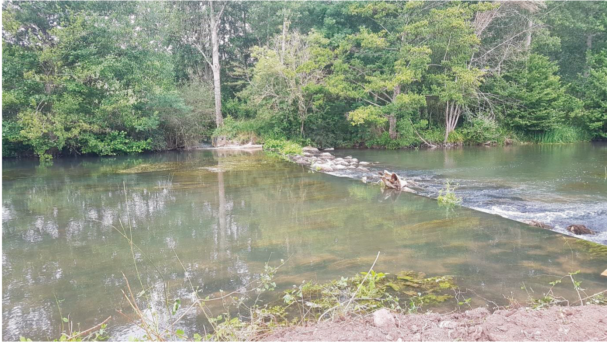
Vue du seuil avant travaux – Petit barrage existant sur le Loing
