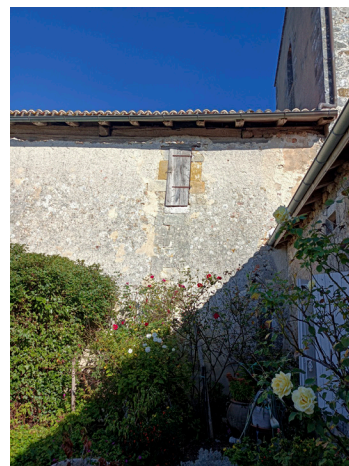
Lucarne côté sud de l'église, donnant sur la voûte
