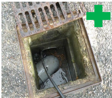
avaloir eau pluviale avec décantation
