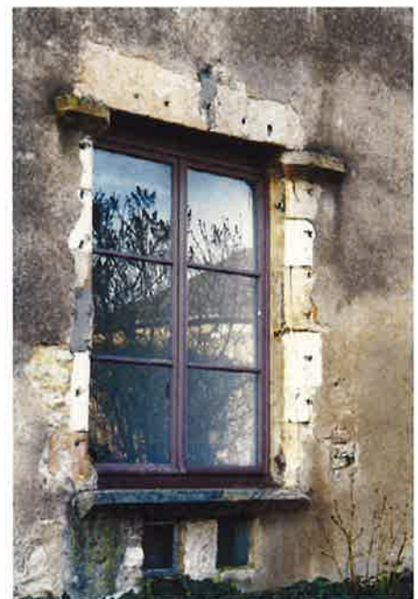
Fenêtre gothique nord en-dessous, les ouvertures d'un "potager"
