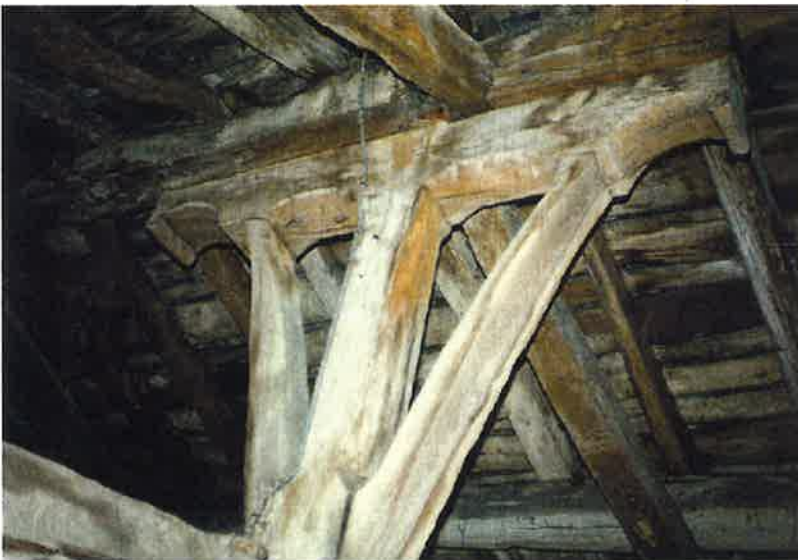
Une charpente unique...
