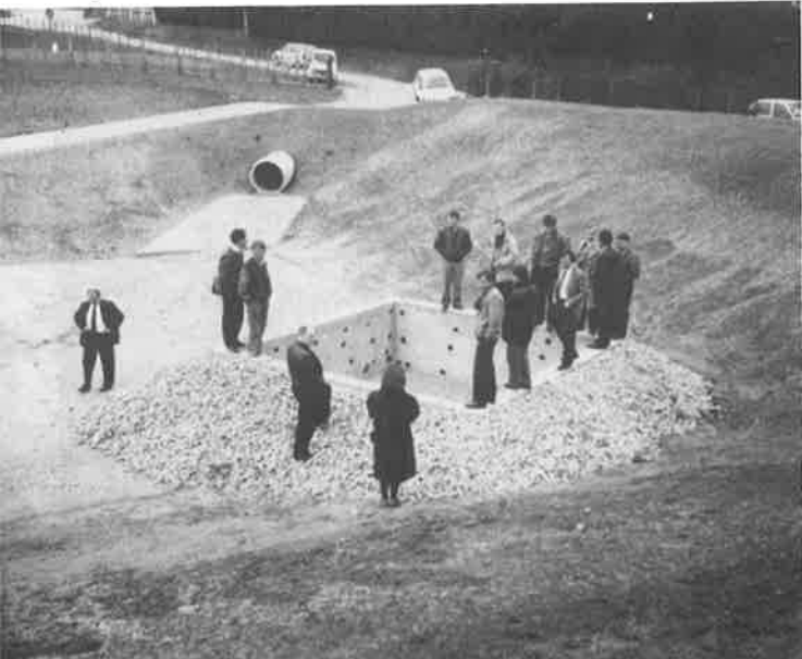
Travaux en chantier sur le secteur.
