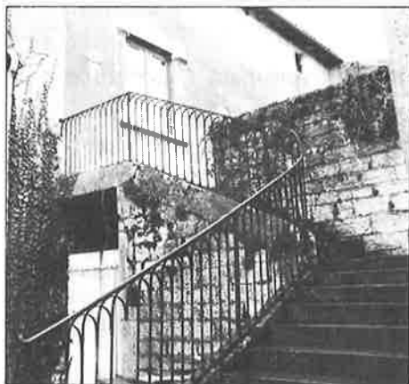
L'accès à la nouvelle salle côté Nord, depuis la place de l'église par ce bel escalier qui aurait lui aussi besoin d'un rajeunissement.
