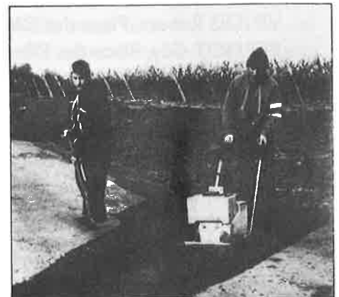
Les cantonniers au travail sur le chemin des Condemines.
