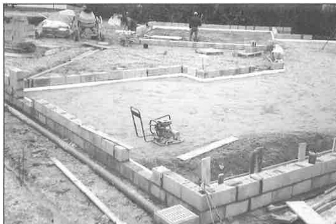
Chantier des installations sanitaires
