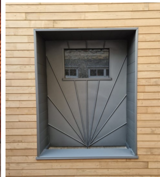
Niche pour pot de fleurs en zinc quartz en cassette avec ourlets gironnés à la galerie d'Art de Chrystèle Ferron (Nasca) à Vitré.
