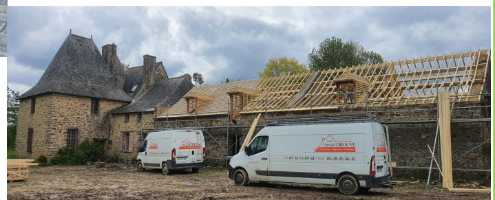
Couverture en ardoises naturelles du Brésil à Montautour
