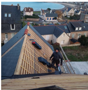
Couverture d'une habitation neuve en ardoises naturelles à Erquy
