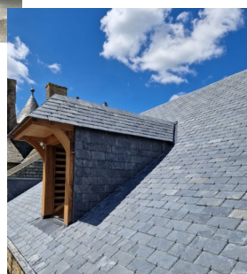
Réhabilitation d'une charpente et couverture avec lucarne Capucine
