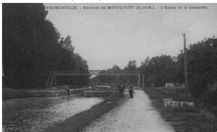
La passerelle métallique
