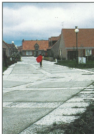
LOTISSEMENT ET CHEMIN PIETONNIER
