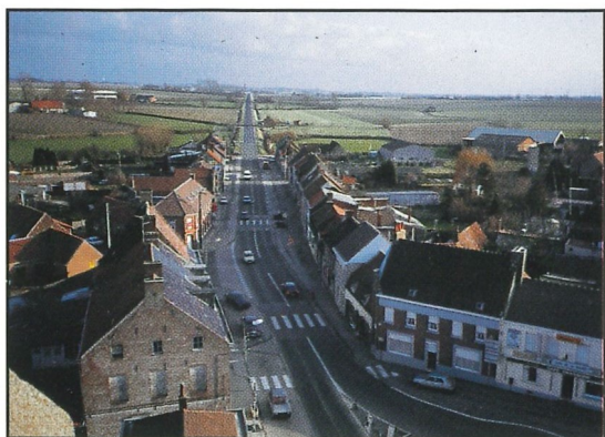
VUE AERIENNE : ROUTE DE BAILLEUL
