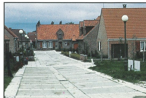
LOTISSEMENT ET CHEMIN: PIETONNIER
