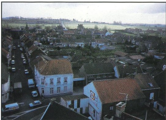
VUE AERIENNE : RUE TERNYNCK
