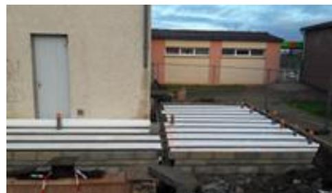
Les plafonds ont été enlevés, les murs des toilettes et cuisine démolis, les ouvertures dans les murs obturés, l'amiante enlevée du poteau extérieur, les fondations des agrandissements creusées, et les réseaux extérieurs posés.
