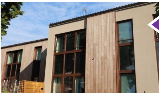
Logement sociaux Face sud
