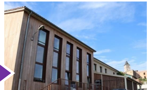
Logement sociaux Face nord
