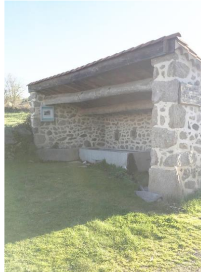
Bassin couvert Photo Archipat
