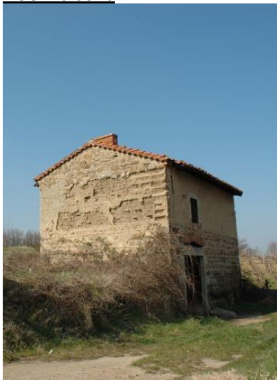
Loge en pisé et soubassement pierre Photo Inventaire général du patrimoine culturel
