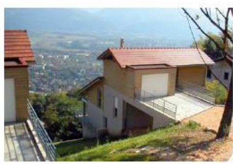
Accès par terrasses et passerelles
