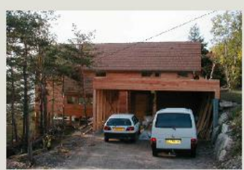
accès latéral, par le haut, parallèlement aux courbes de niveau en peut remarquer la réalisation des outènements des talus créés
