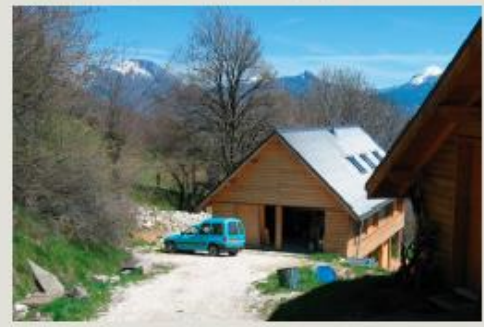
accès par le chemin le plus court, stationnement et garage en partie haute
