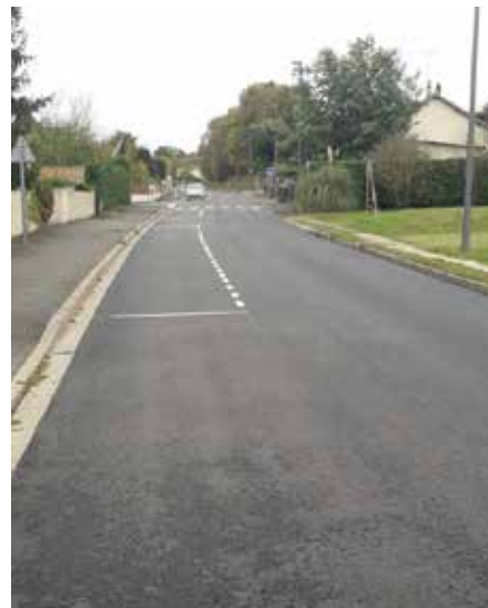
Rue du Servolet.
