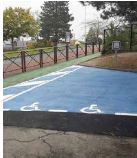
Place de parking au Gymnase du Bois Foucher.
