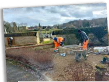
Création d'un puits de dispersion des cendres dans le nouveau cimetière.
