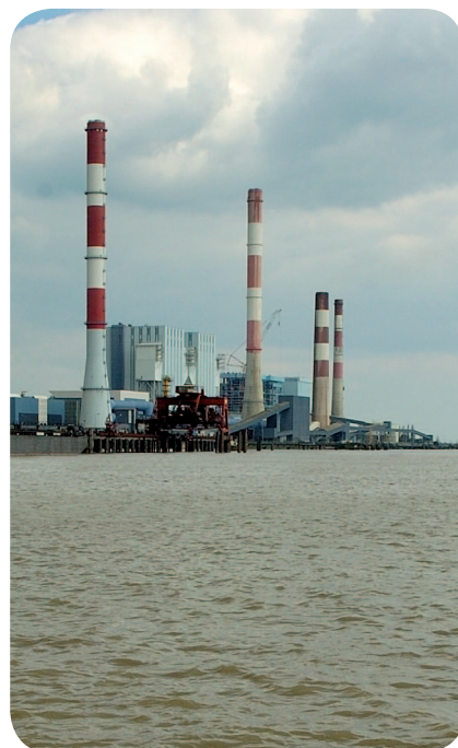
La centrale électrique de Cordemais constitue le plus gros site thermique à flamme français d'EDF
