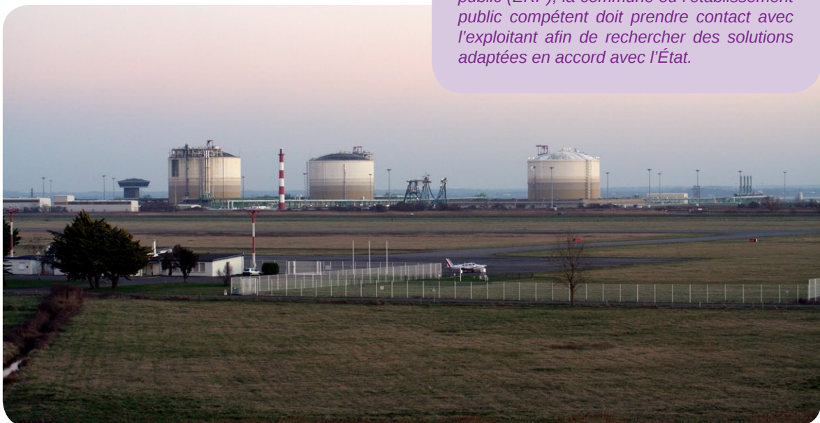
Terminal méthanier de Montoir-de-Bretagne
