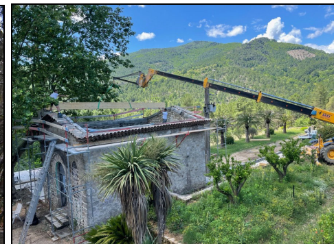
Façade nettoyée et pose de la toiture
