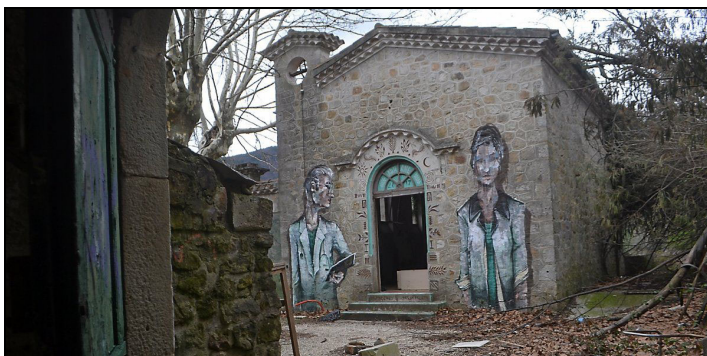
Façade Est en 2019
