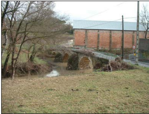
Le vieux pont de la Jasse-de-Bernard, submergé par la crue. Le lit mineur ne représente qu'un tiers de la capacité des arches
