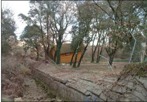
Le camping de Rousson, en rive droite de l'Avène, dévasté par la crue
