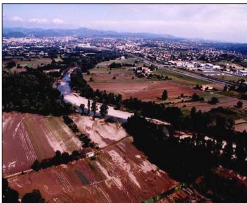
Point de sortie du Gardon au droit de Montmoirac, à l'aval d'Alès. (photo Strategis)
