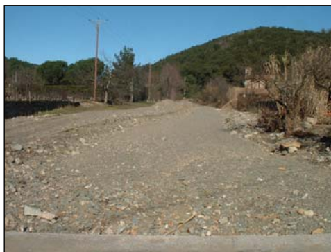
Transport solide et remblaiement du lit mineur du Rieusset en amont du pont de Malataverne
