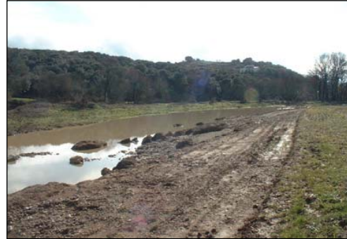
Creusement d'un lit de crue parallèle au cours de l'Avène, dont on aperçoit la ripisylve à l'arrière plan
