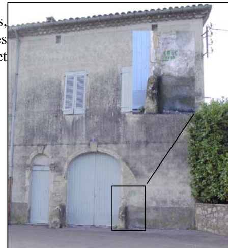
Photo 26 : Repère de la crue de 1958 à la Haute Prairie
